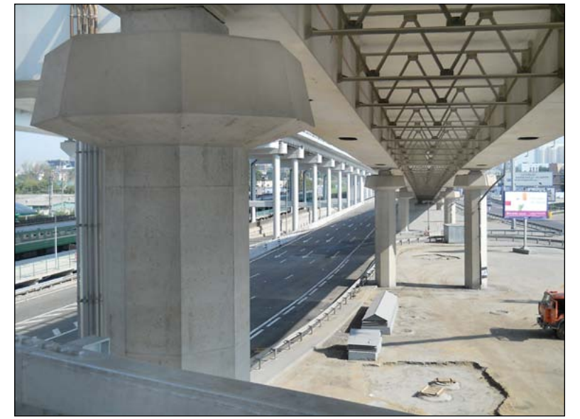
Причем все работы на «Тестовской» велись без остановки движения по этой довольно-таки загруженной железнодорожной ветке.
