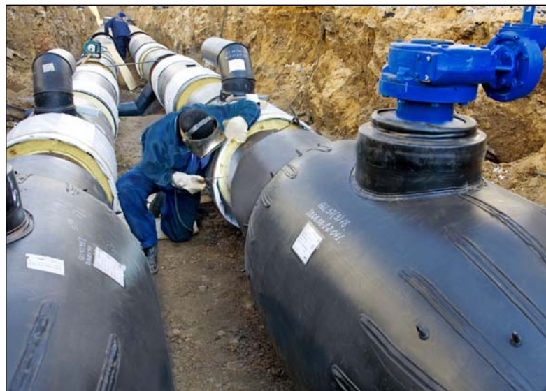
Строительство тепловых сетей.
