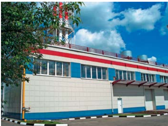
Автоматизированная котельная, построенная в г. Щёлково
