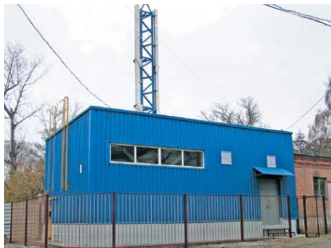
Блочно-модульная автоматизированная котельная
