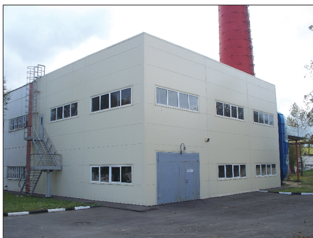
Рис. 4. Котельная КТС-044, в которой установлено 3 газопоршневых агрегата.
