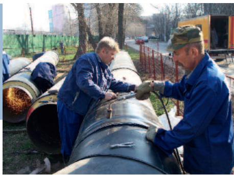
Рис. 4. Выполняются изоляционные работы на строящейся тепловой сети к новому жилому комплексу.
